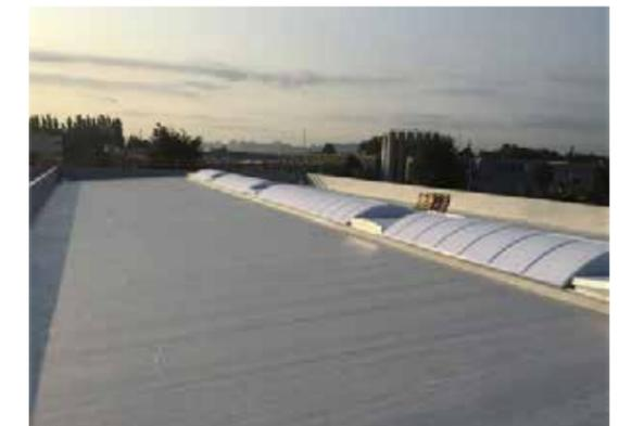
Le PVC est utilisé dans le monde entier comme membrane thermoplastique pour l'étanchéité des toits plats industriels. Pour des raisons économiques et de facilité de pose, le PVC reste aujourd'hui l'un des films de toiture les plus courants.
