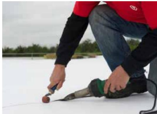
MUTEK est le pionnier et le leader du marché de la pose de membranes TPO au Benelux. Cette membrane de toiture flexible est idéale pour les toits plats commerciaux et industriels à faible pente.
