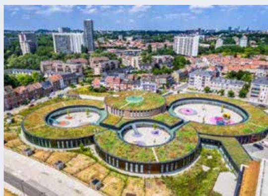
Les toitures végétalisées et les panneaux solaires créent tous deux une charge permanente sur la surface du toit et nécessitent donc une attention particulière lors de la mise en œuvre de la structure de toiture.
